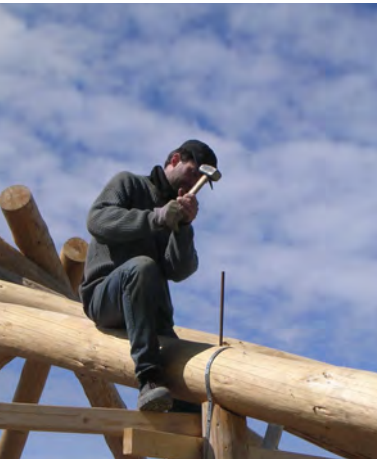
Bærende trækonstruktion af lokalt fældet rundtømmer
